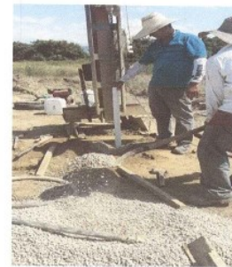
Figura No. 12 piezómetros No. 2, Terminación final.
